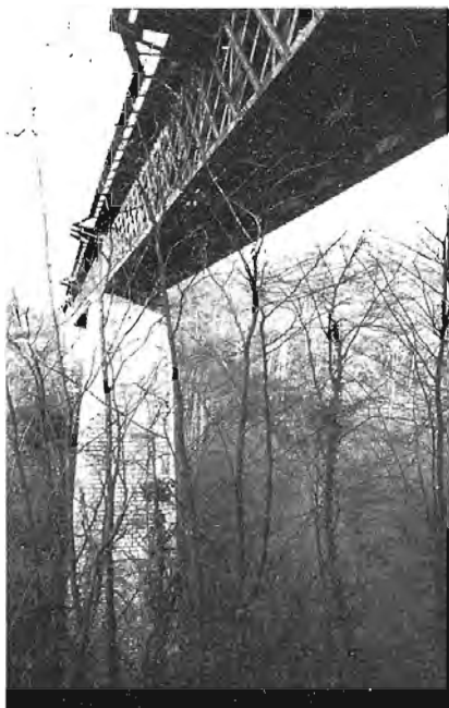
Le viaduc SNCF du Grenan
