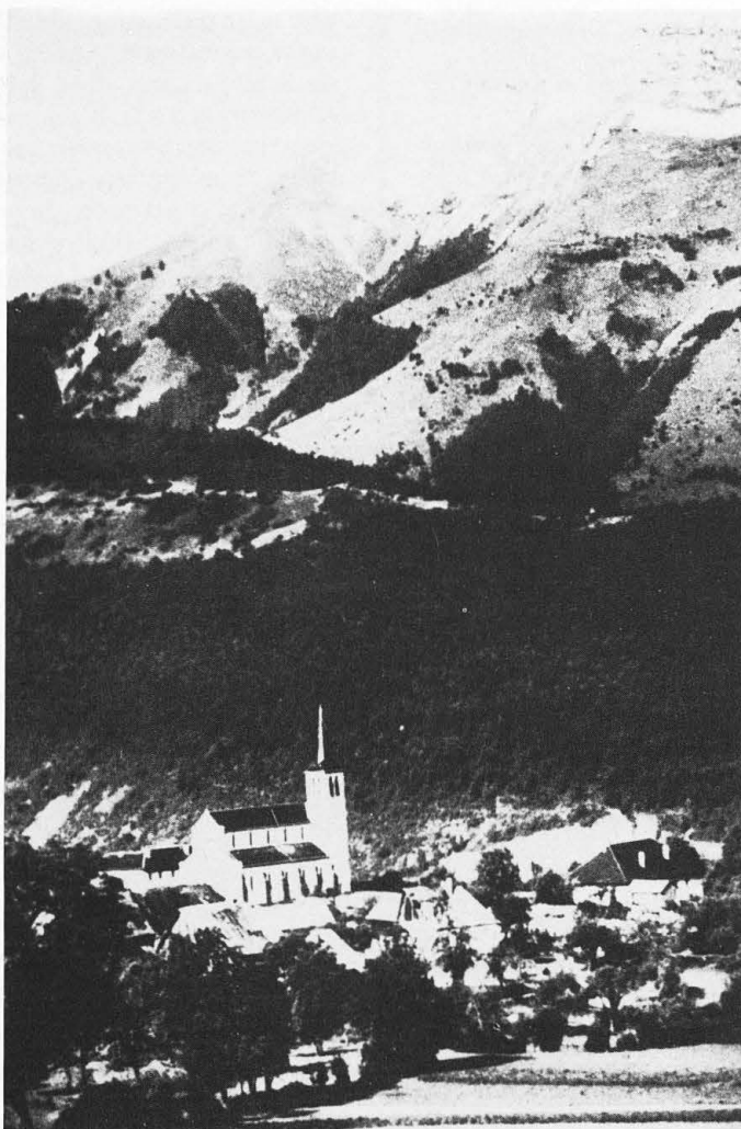
Une partie du village (Cliché A. Palluel-Guillard).
