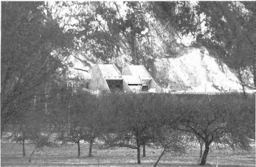
L'entrée du tunnel de l'autoroute A. 43 (Photo R. Gariod)
