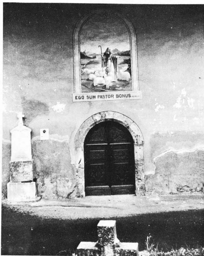
Détail de la façade de l'église (cliché B. Baudouy).
