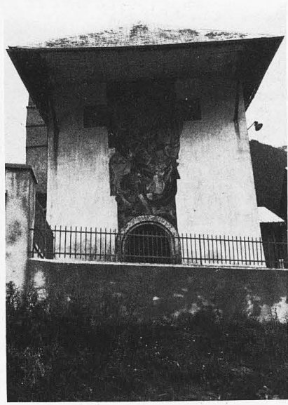
Détail du porche de l'église (cliché B. Bau-douy).
