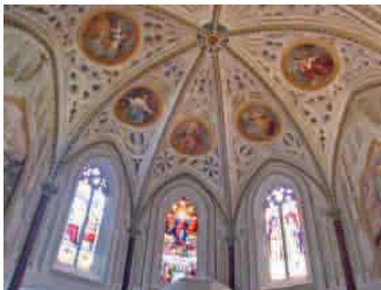
Vue du décor peint de la voûte du chœur.
