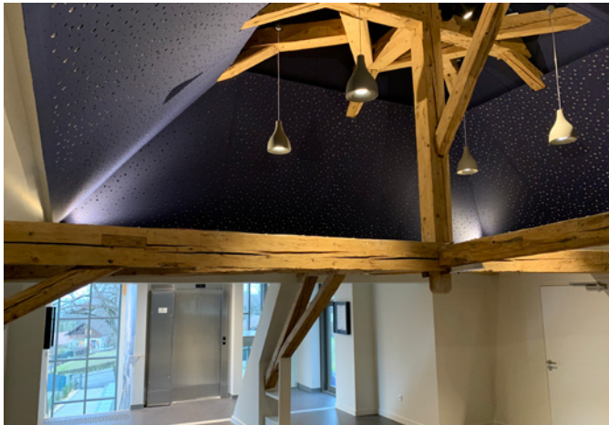
fig. 13. Le volume du comble et la charpente.
