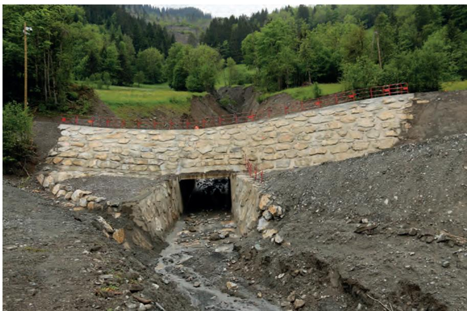
Ouvrage pont cadre finalisé avant pose du revêtement de chaussée
