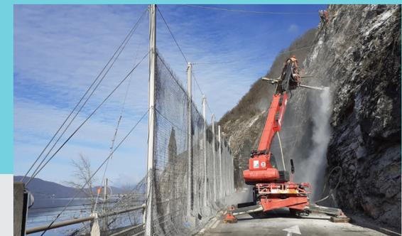
Forage mécanique avec un gyroscopique
