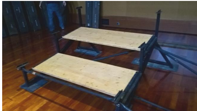
Installer les planchers
