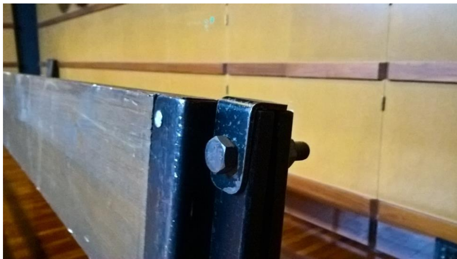
Installer le dossier et les bloqueurs
