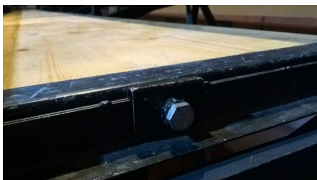
Installer les 5 bloqueurs au bout des bancs et planchers
