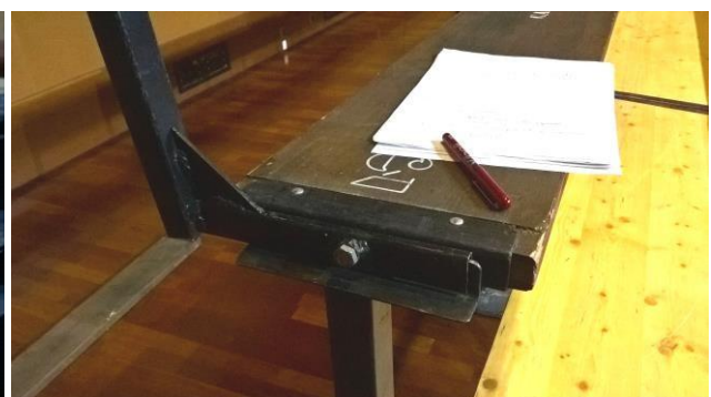
Installer les 5 bloqueurs au bout des bancs et planchers
