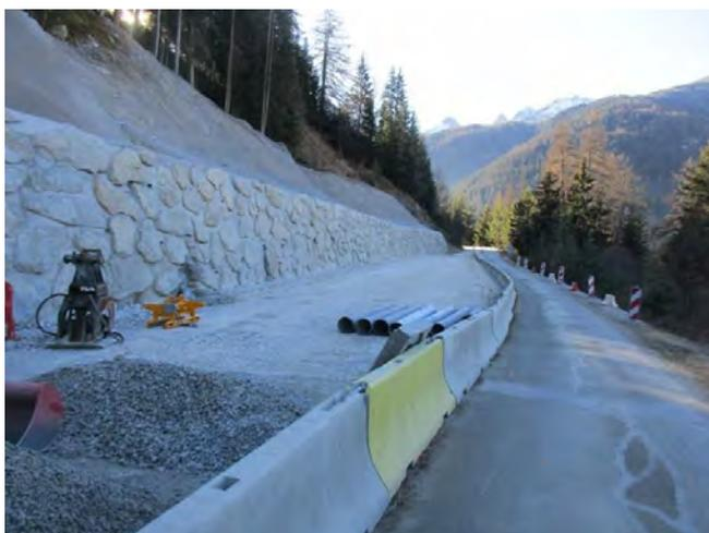
RD216 - Stabilisation d'un glissement sur la montée à Valfréjus
